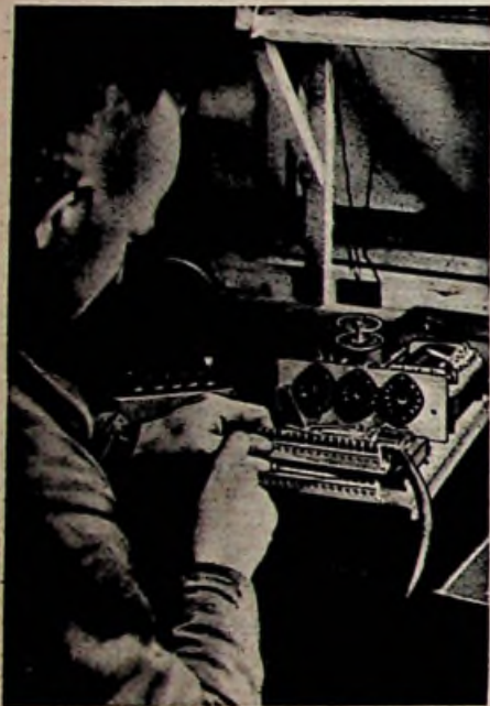
Montage einer 5stelligen Zentrale der Gegensprechanlage der Firma BITO-Tonstudio Kurt Sandmann. Im Bilde links eine Sprechstelle
